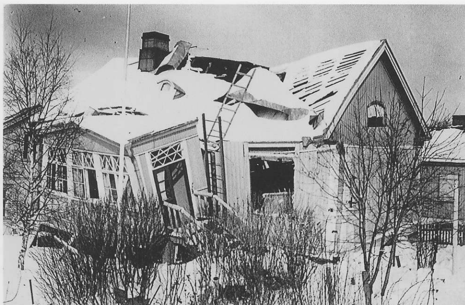
Heinosten talo Kaakontie 12:ssa vaurioitui pahoin talvisodan aikaisessa ilmapommituksessa. Tapahtumahetkellä perheen äiti ja Pentin sisko Raili olivat Nekalan kansakoulun väestönsuojassa. Perheen isä oli töissä Verkatehtaalla ja Pentti itse oli Tammertehtaan varastossa töissä.
