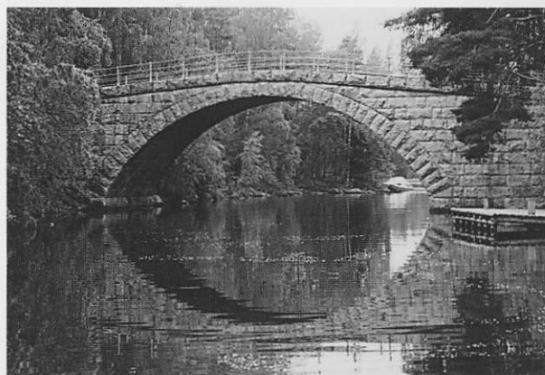
Aunessilta rakennettiin "kivenhakkurien" ja "timpermännien" voimin 1898–1899. Kaunis yksikaarinen kivisilta on nykyään museosilta.
