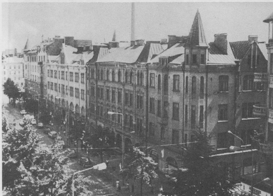
Kauppahallin virastotalo keskellä 1972
